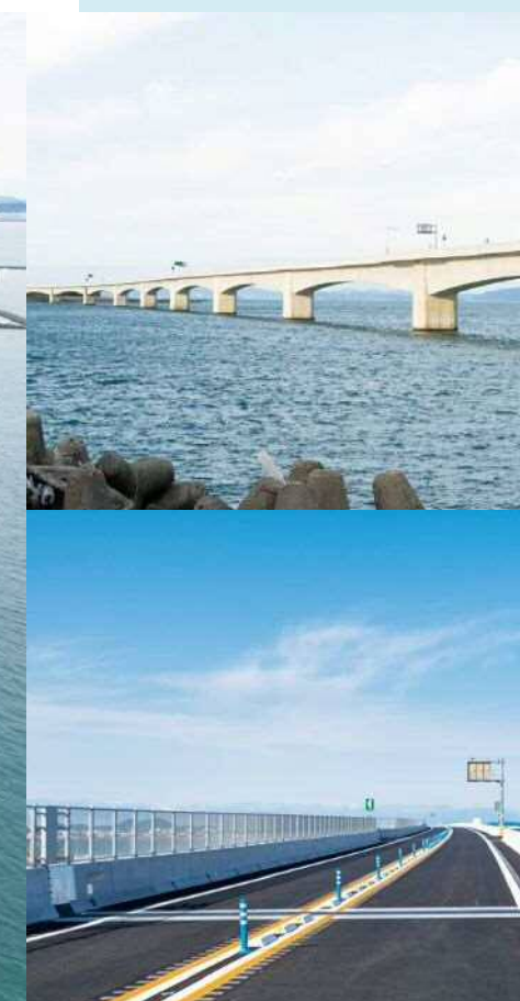
徳島南部自動車道
